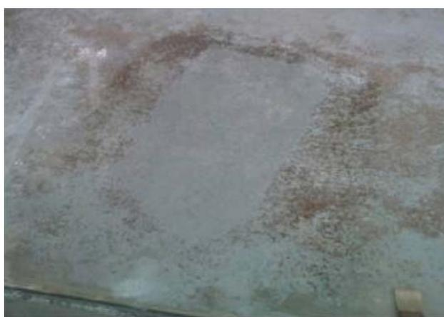
**Figura 3.-** Aspecto de una zona recuperada por medio de un limpiador bioquímico.
