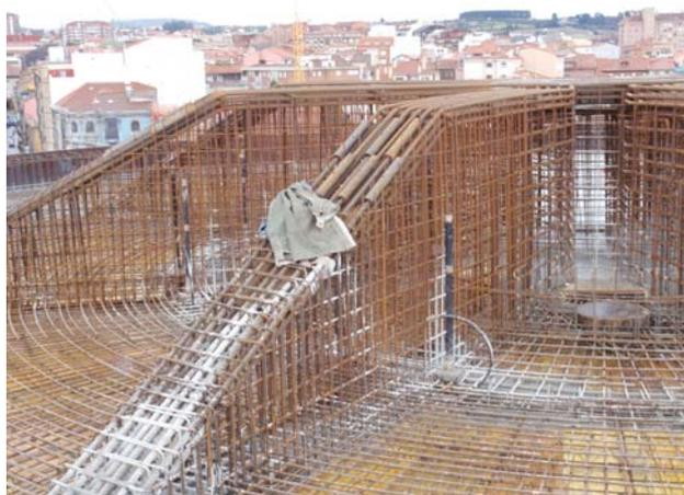
Figura 14.- Armado de las vigas de cubierta de la Torre-Mirador.
