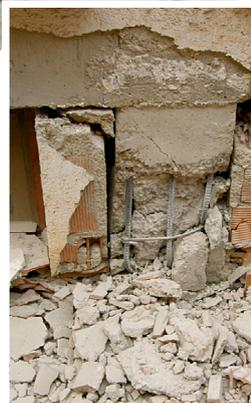
(1) Los elementos de compartimentación y de cerramiento, teóricamente no resistentes, pueden tener un efecto determinante en el daño estructural de pilares cuando constituyen un relleno (infilling) total o parcial de los marcos estructurales.
