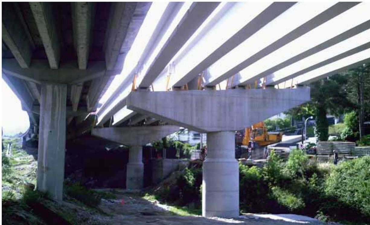
➡ **Fotografía 3.-** Aspecto de una estructura tras la aplicación superficial de los inhibidores MCI (Autopista de peaje A-6).
