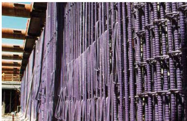
⇒ **Fotografía 4.-** Aplicaciones de los aceros recubiertos con epoxi en muros.
