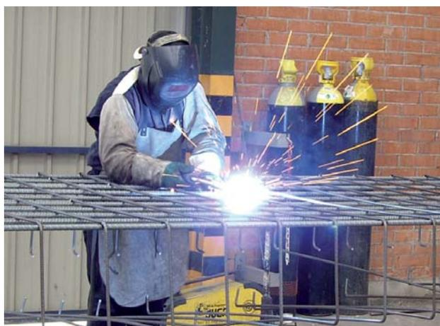
Figura 1.- Soldadura en la elaboración de armaduras pasivas.
