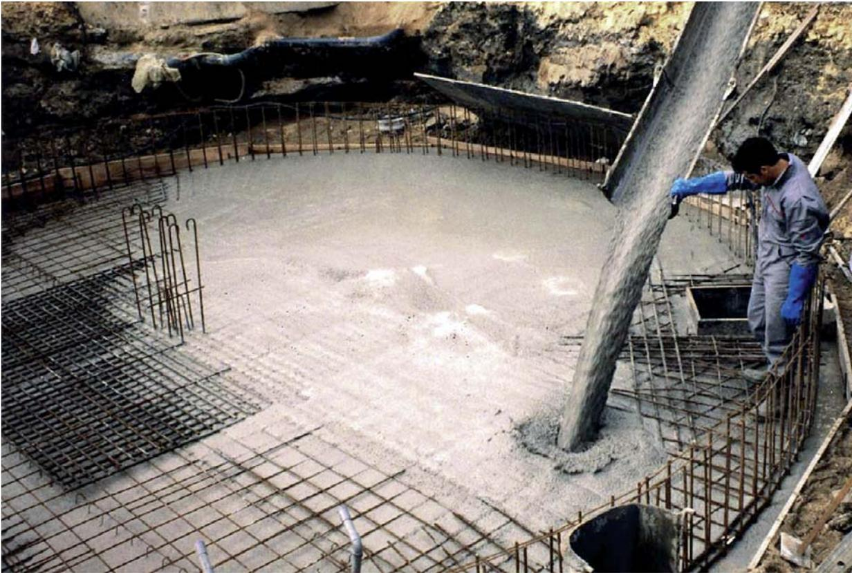
Figura 1.- Ejecución de una losa con hormigón autocompactante.
