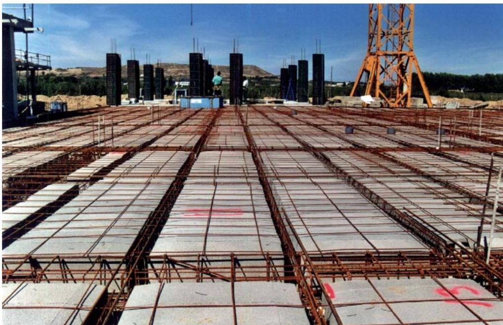
Figura 3.- Forjado unidireccional con armadura básica electrosoldada en celosía, construido in situ.
