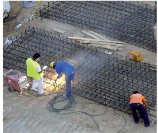
Figura 5.- Soldadura en obra.
