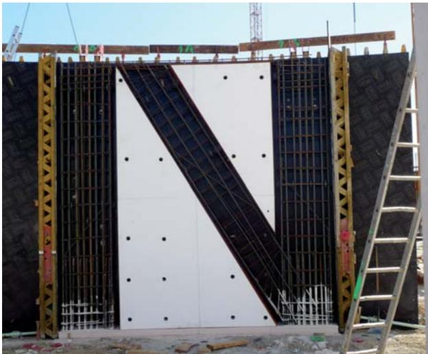
⇒ **Figura 5.-** Detalle de moldes de poliestireno en encofrado perimetral.
