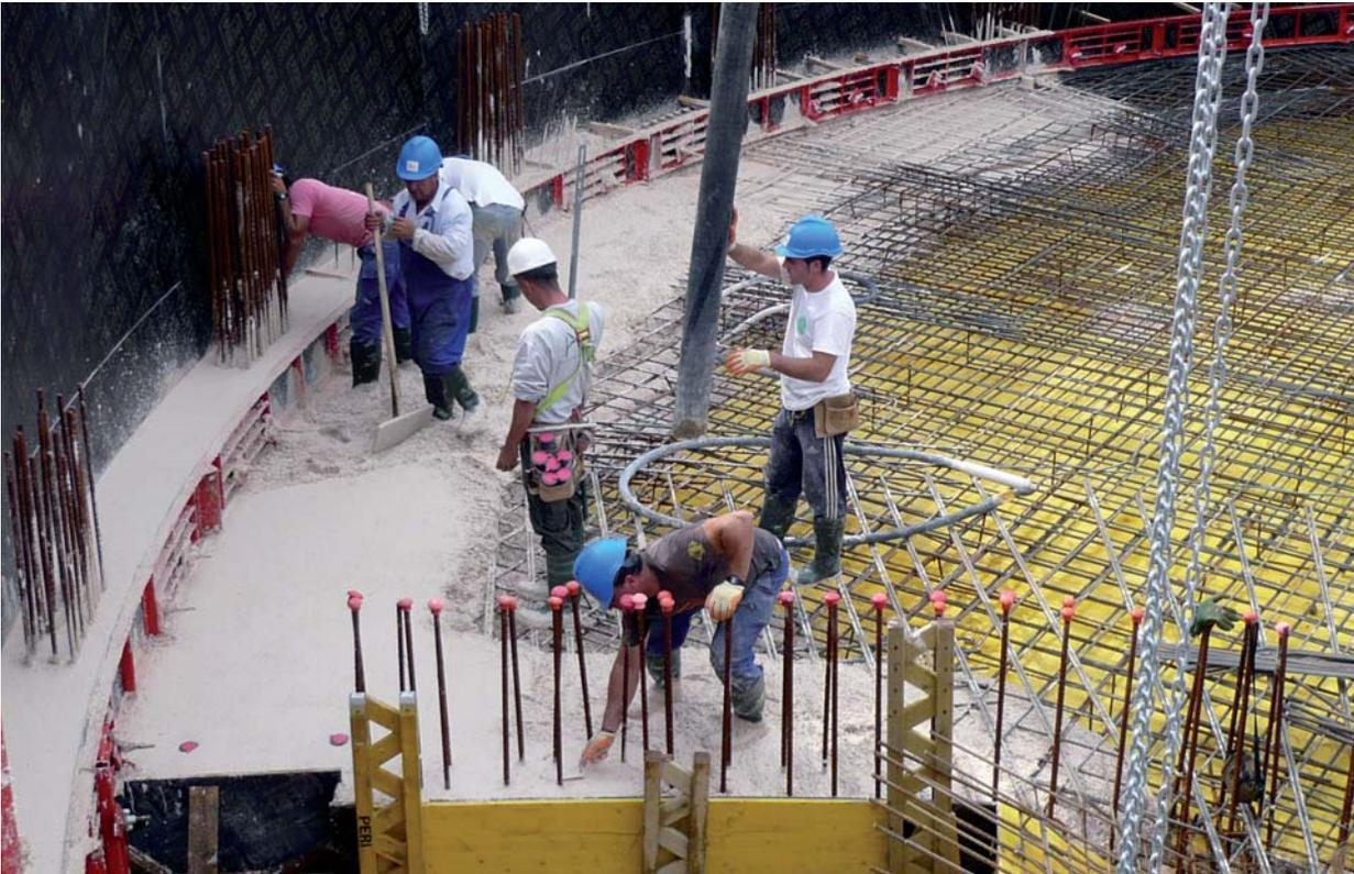
Figura 11 - Hormigonado de la losa.
