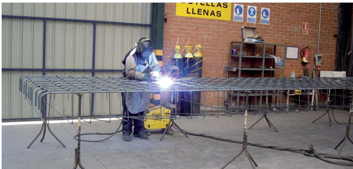
Figura 8 - Soldadura en instalación de ferralla.
