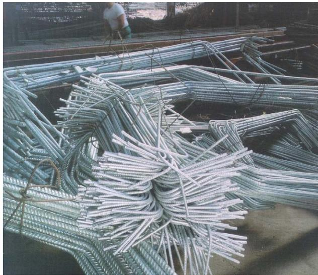
Instituto Eduardo Torroja, habló sobre la galvanización en caliente del acero y las armaduras pasivas, como forma de protección de éstas frente a la corrosión, aumentando la vida de servicio de la estructura, disminuyendo las actuaciones de reparación como consecuencia de la presencia de ambientes agresivos y haciéndolas, en definitiva, más sostenibles.
