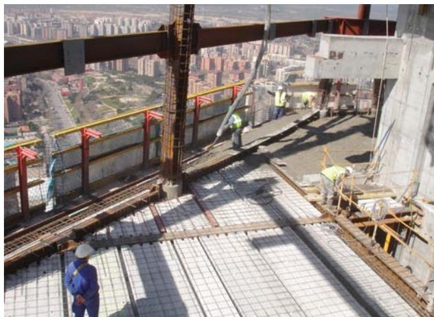
⇒ **Figura 10.-** Torre de Cristal: solución de losas alveolares utilizada para los forjados de la estructura.
