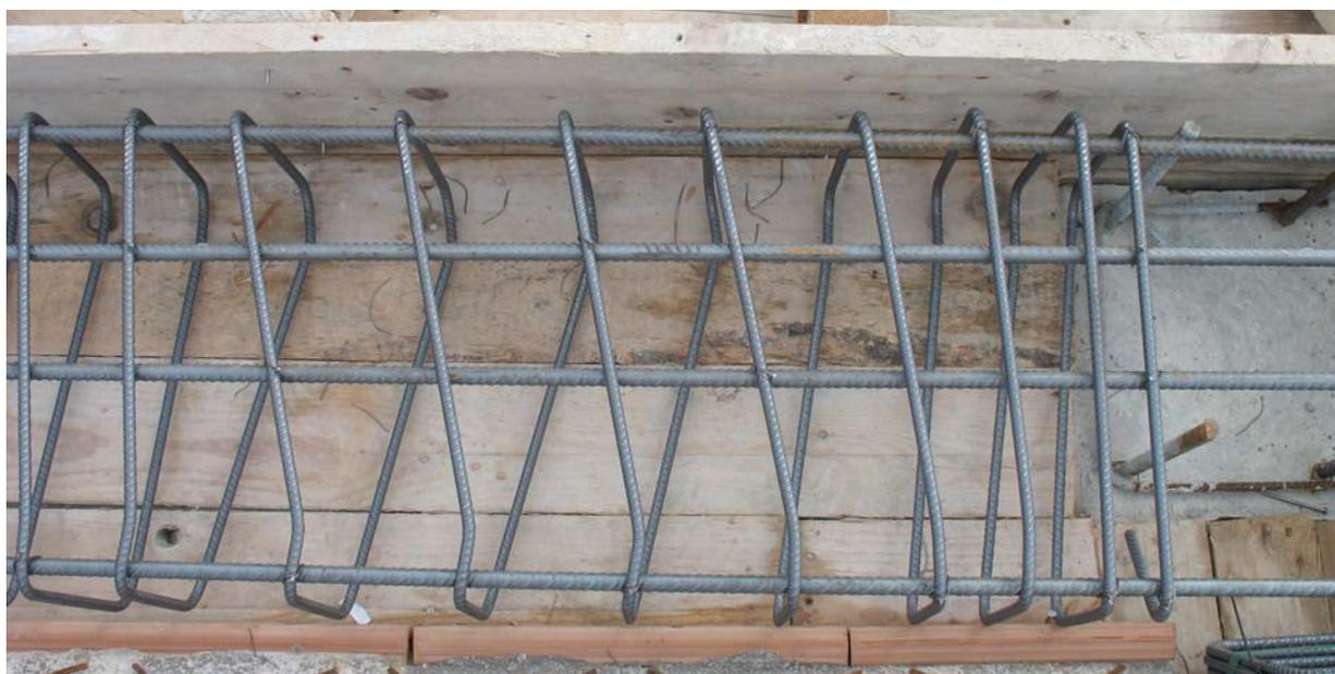
Figura 5.- Estribo continuo con esquema en forma de M.
