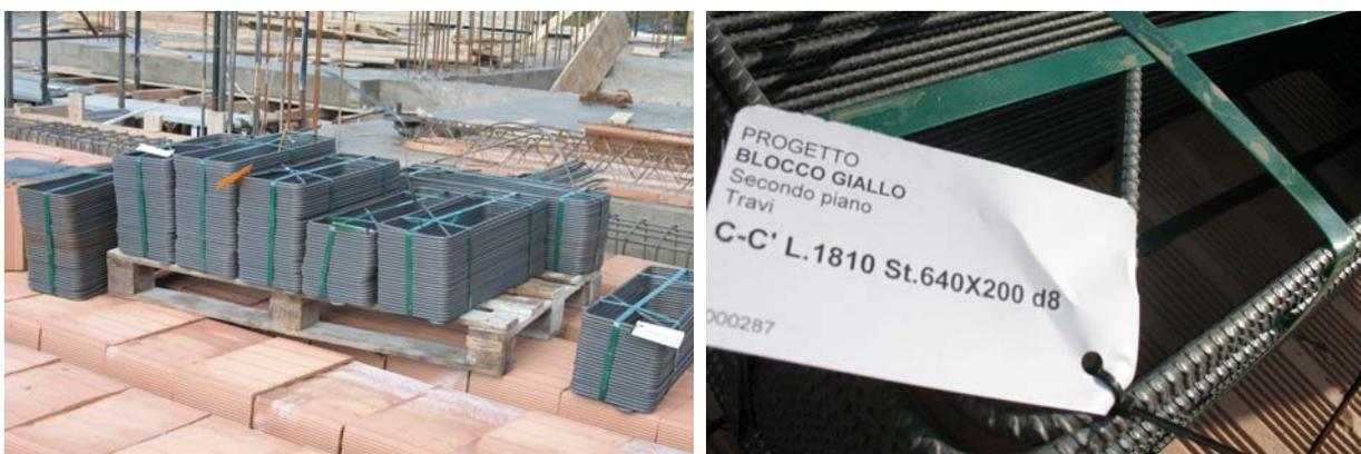
Figura 10.- Acopio y trazabilidad del estribo continuo.
