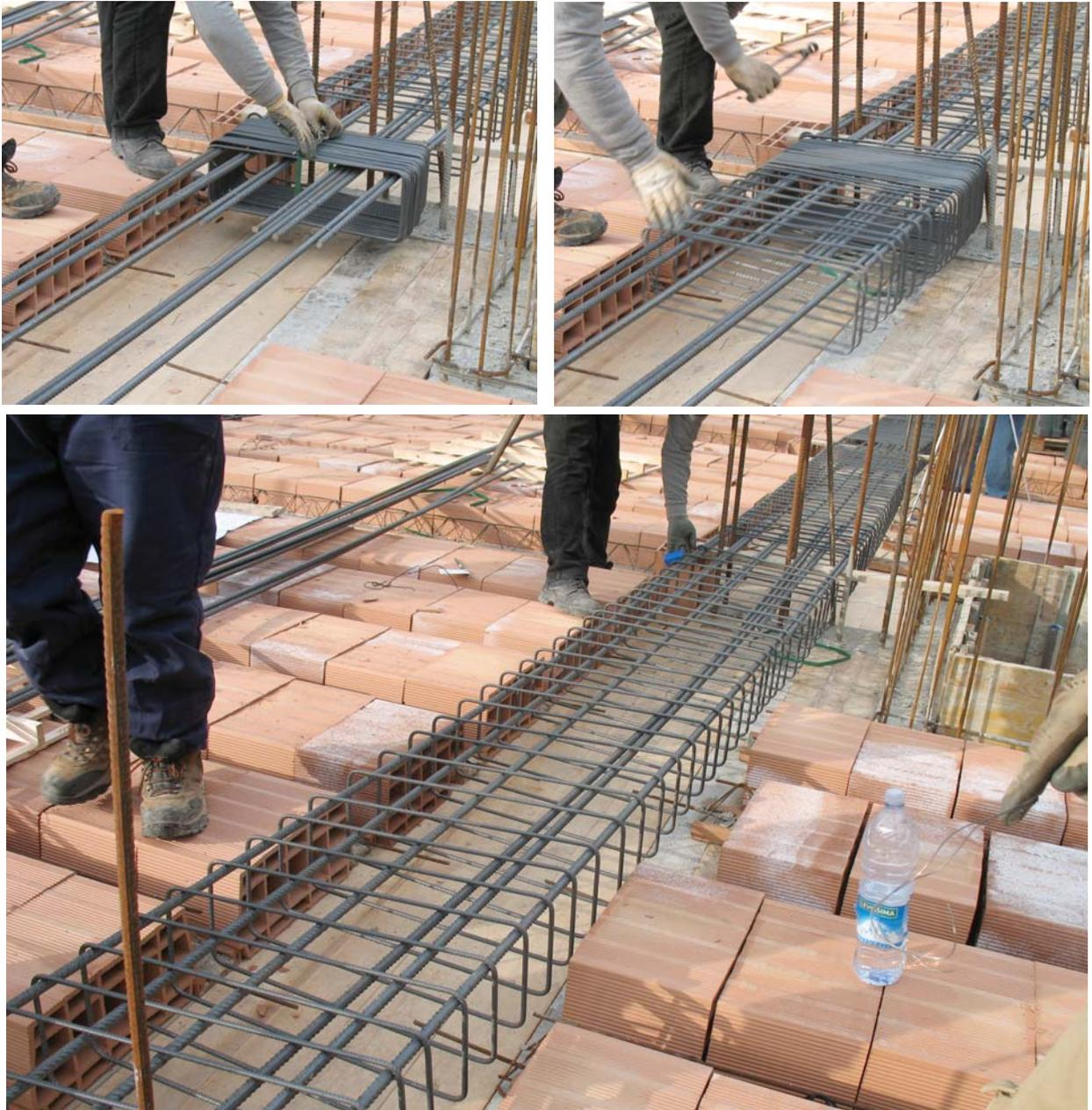
➔ **Figura 4.-** Colocación en obra del estribo continuo.
