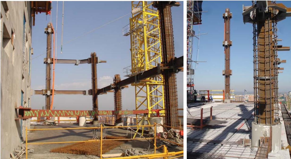
Figura 5.- Torre de Cristal: ensamble de los pilares compuestos.
