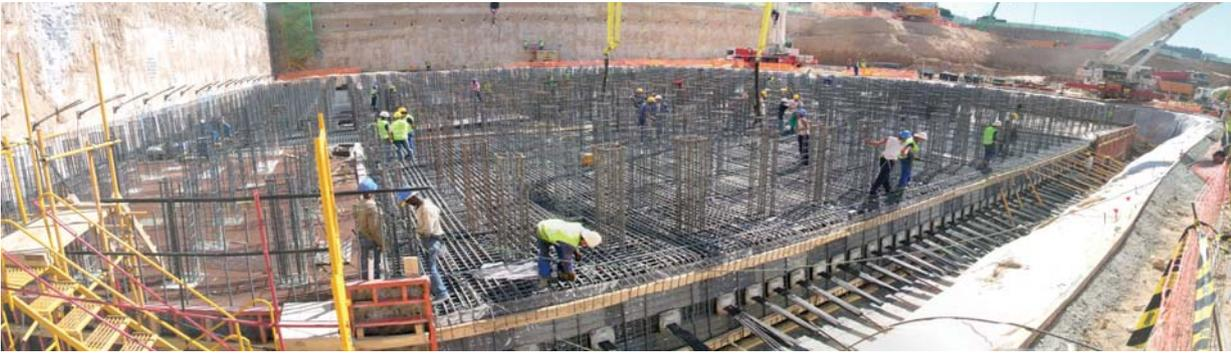
⇒ **Figura 2.-** Vista general de la losa de cimentación de Torre Espacio en la que se aprecian los cables de pretensado.
