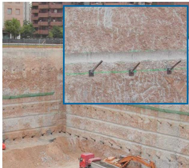
Figura 4.- Pantalla con rozas preparadas para la unión con los forjados.
