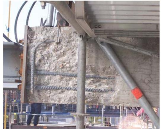
Figura 10.- Fallo en una placa de anclaje por mala ejecución.
