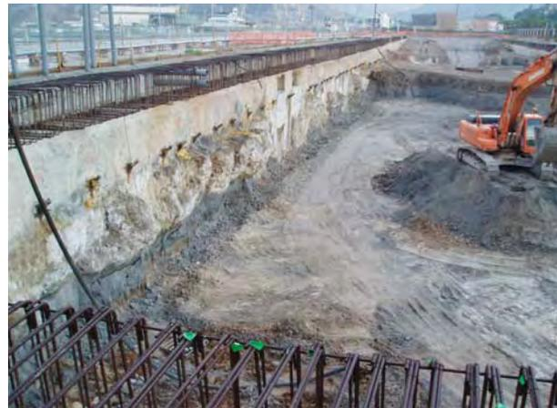
Figura 4.- Ejecución y vista general de los anclajes multibulbo.
