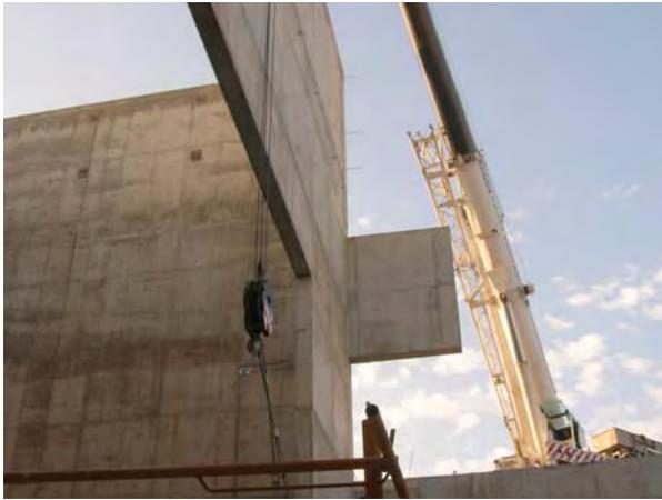
⇒ **Figura 16.-** Detalle de ménsula en caja escénica para el apoyo de la cercha de fachada.
