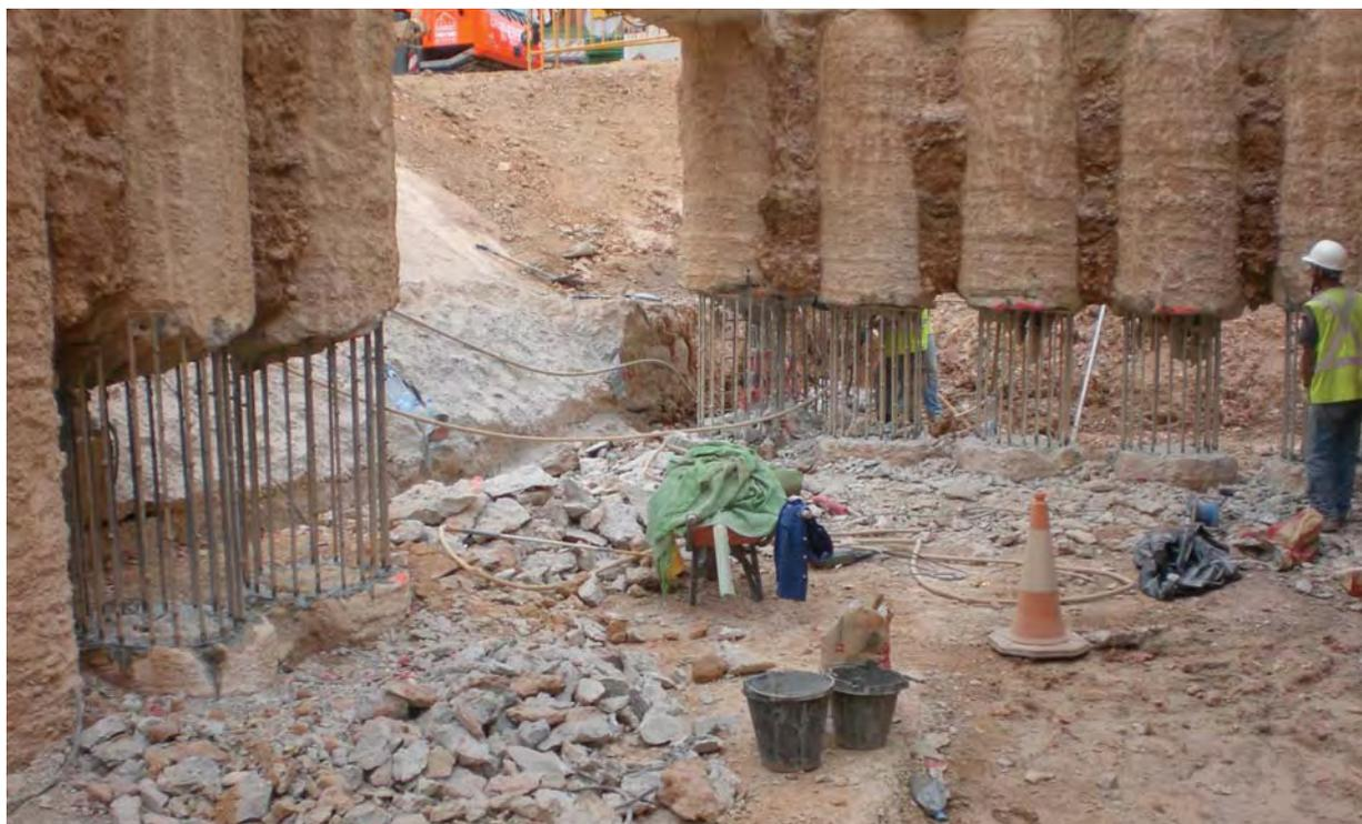
Figura 3.- Pilotes de 900 mm de diámetro demolidos para poder unirlos con la bóveda a ejecutar (Intercambiador de Sabadell).
