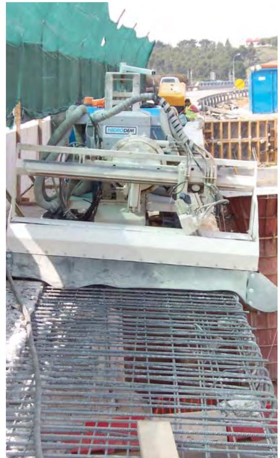
Figura 5.- Tablero de 30 cm de canto de hormigón HA-30 en el que se descubrieron las armaduras en una anchura de 1,20 metros (Ampliación de tablero en las obras de la AP41 Madrid-Toledo).
