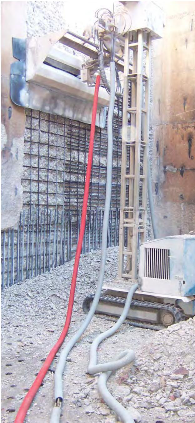
⇒ **Figura 7.-** Hidrosaneado superficial de muros de hormigón (HA-35) afectados por la acción del fuego antes de su puesta en servicio (EDAR Arroyo de la Miel en Bendímadena - Málaga).
