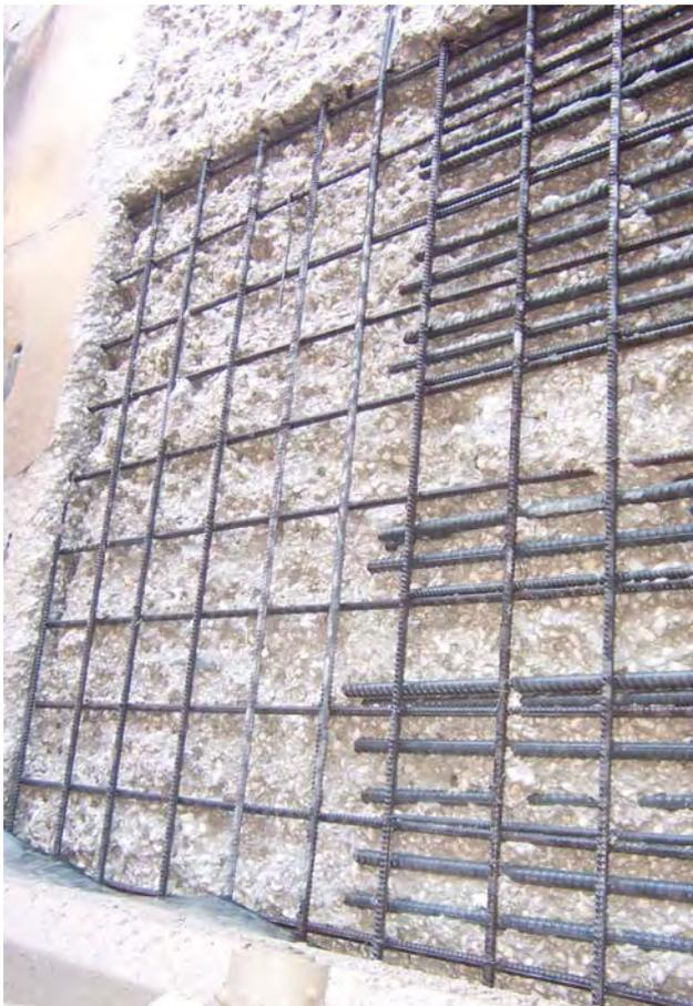
Figura 4.- Aspecto de la superficie final resultante de una zona saneada para efectuar su reparación (EDAR Arroyo de la Miel en Benálmadena-Málaga).
