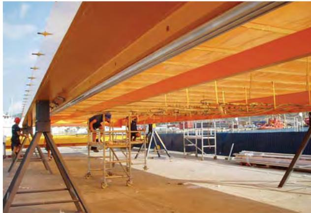
Figura 20.- Instalación de las láminas de ETFE en los bastidores.
