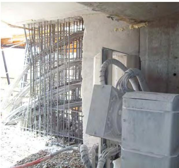
**Figura 6.-** Rescate de la armadura activa en la sección artesa de un viaducto, en el que, por falta de confinamiento, se produjo la rotura del hormigón (HA-40) en el momento del tesado (Obras de Viaducto sobre el Río Tajo en Toledo). Robot posicionado antes de la ejecución y detalle del resultado final.
