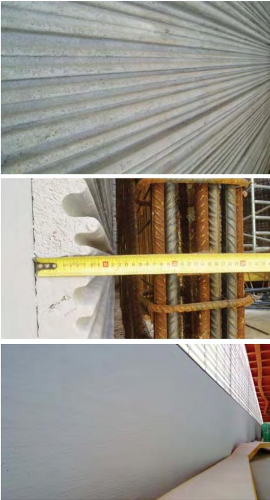
Figura 8.- Texturas del hormigón en los muros.
