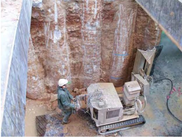
Figura 1.- Robot trabajando con el brazo en posición vertical en la demolición controlada de pilotes (Intercambiador de Sabadell).
