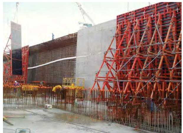
⇒ **Figura 7.-** Muros-forro perimetrales en diversas fases de ejecución.
