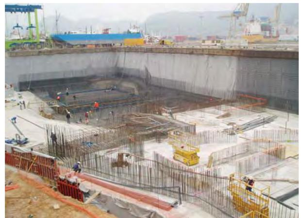
⇒ **Figura 6.-** Cimentación constituida por losas de diferentes espesores según su profundidad.
