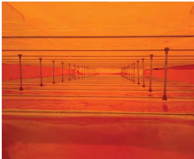
Figura 21.- Vista interior: sistemas de cables enfundados y conectados mediante bielas de aluminio.
