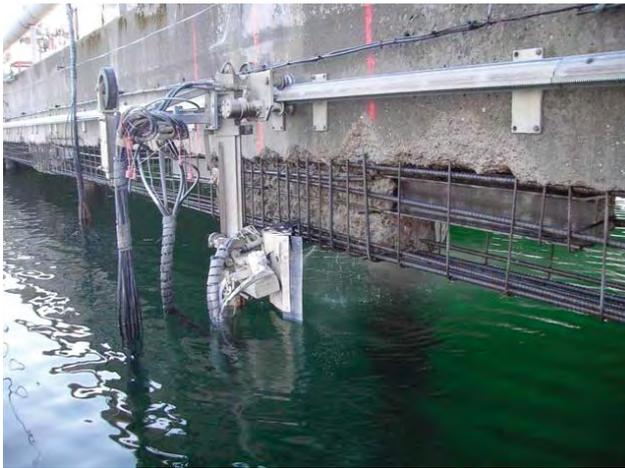
Figura 2.- Robot trabajando incluso bajo el agua.
