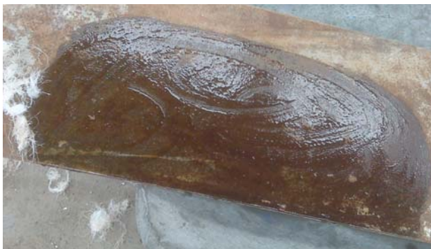
Figura 4.- Aplicación del limpiador bioquímico sobre una zona del encofrado.
