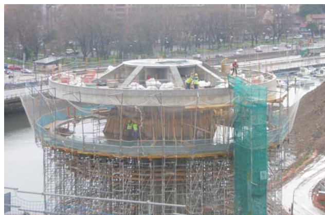
Figura 15.- Ejecución de la Torre-Mirador.
