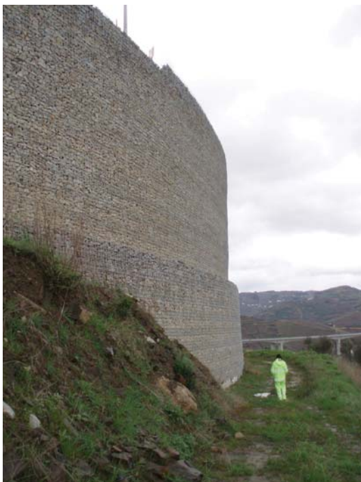
Figura 8.- Muros de tierra armada con paramento de piedra natural (Portugal).
