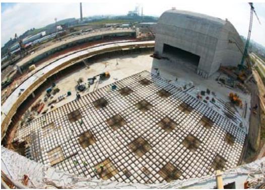
Figura 18.- Construcción del forjado reticular en la Plaza del Centro Cultural sobre el aparcamiento.
