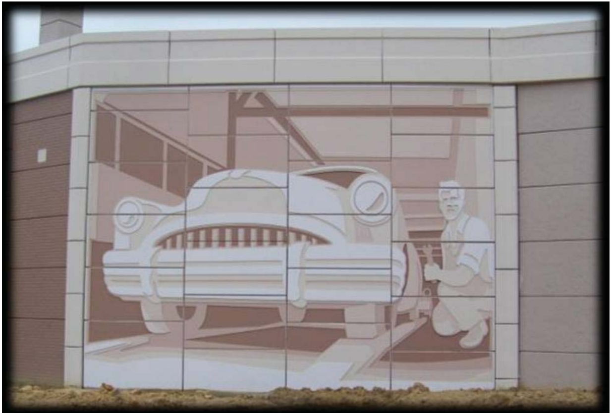
⇒ Figura 17.- Muro con acabado mural con relieve utilizando poliestireno extruido.
