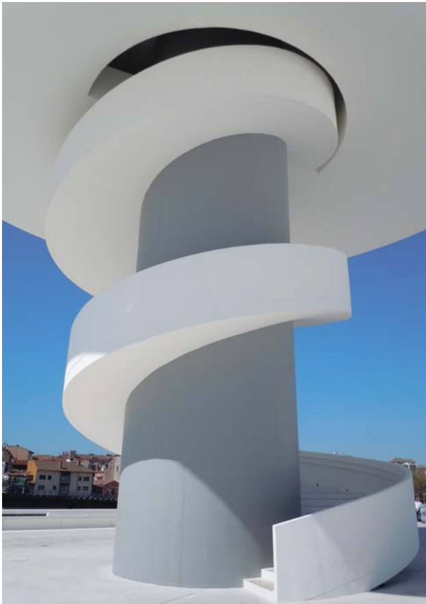
⇒ Figura 16.- Escalera de caracol exterior de acceso a la Torre-Mirador.
