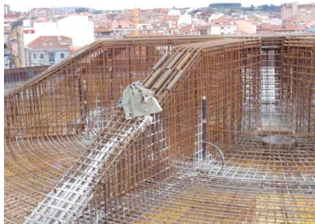
Figura 14.- Armado de las vigas de cubierta de la Torre-Mirador.
