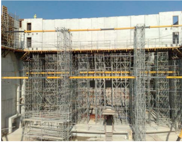
⇒ Figura 8.- Muro telón en hormigón armado durante su ejecución.
