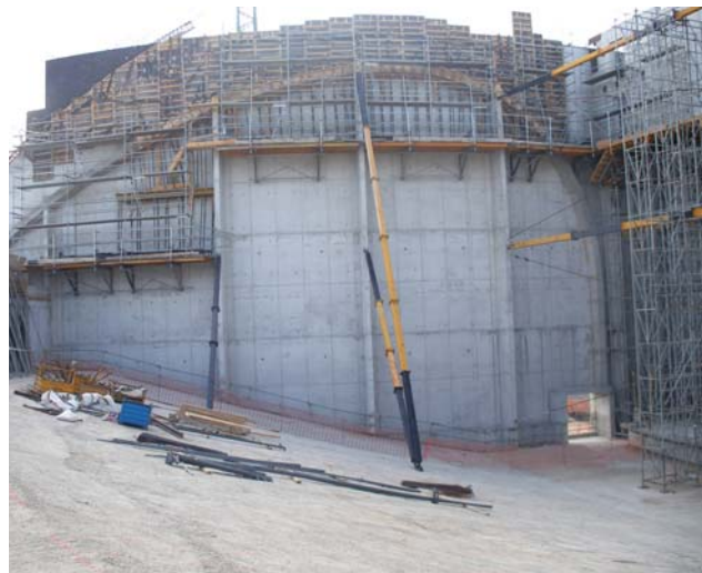
Figura 7.- Ejecución de los muros laterales del Auditorio con arriostamientos temporales.
