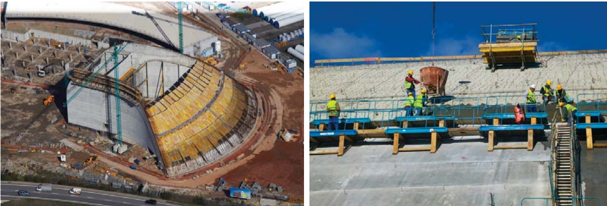
Figura 6.- Distintas etapas de la ejecución de la cubierta del Auditorio.
