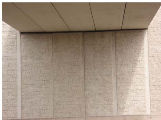
Figura 2.- Acabado texturizado en estribos (Acceso de Los Cardones – Tenerife).
