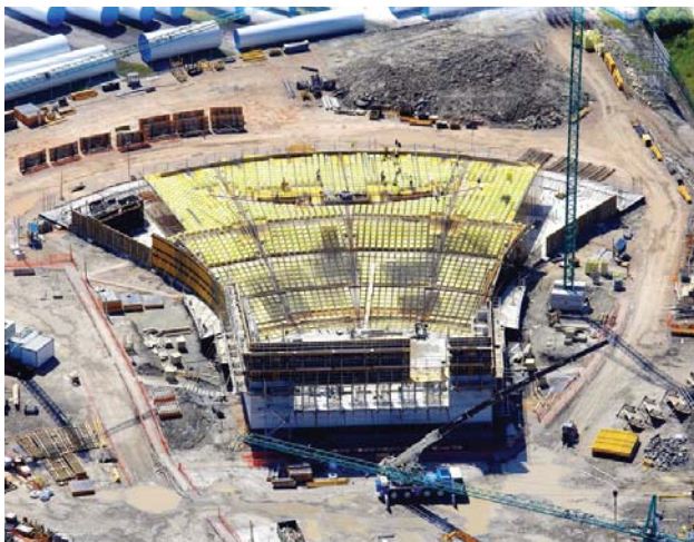
⇒ Figura 9.- Ejecución del forjado reticular del nivel Platea.
