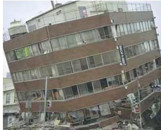
Figura 8.- Fallos estructurales por carga sísmica. Terremotos de Lorca, España, 2011 (izquierda) y Kobe, Japón, 1995 (derecha).
