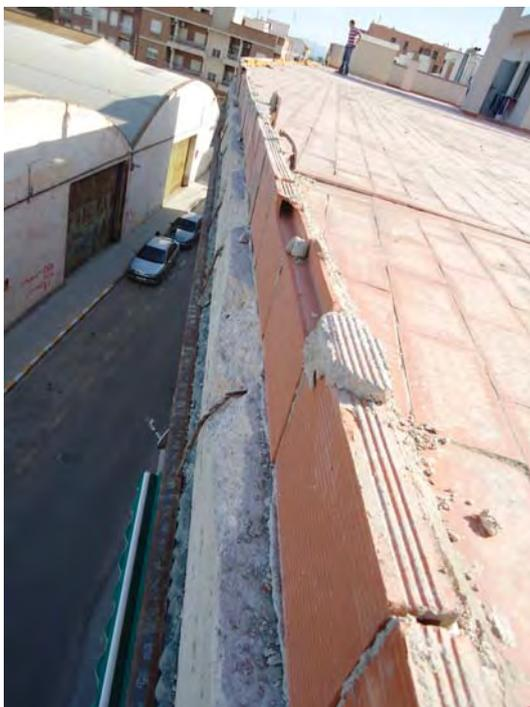
Figura 15.- Detalle del empleo de un perfil metálico, con un precario anclaje, para apoyar la fábrica de ladrillo por delante del forjado.
