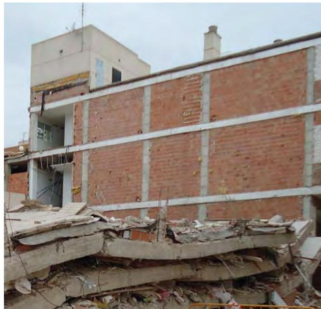
Figura 19.- Detalle de al importancia que la fábrica de ladrillo tiene en el comportamiento estructural del edificio
