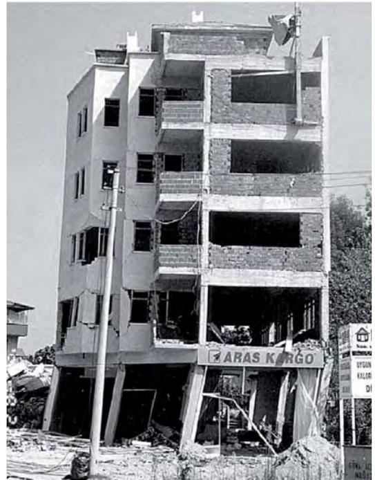
Figura 9.- Ejemplo de edificio con planta blanda dañado [12].
