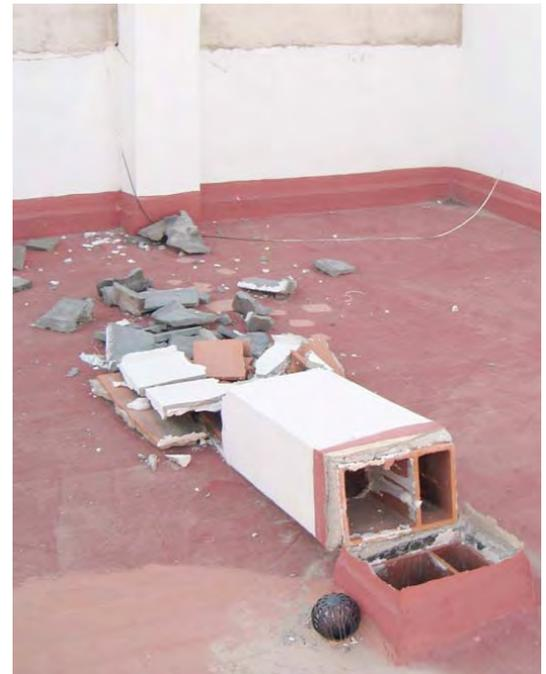
⇒ **Figura 10.-** Colapso de una chimenea en la cubierta de un edificio.
