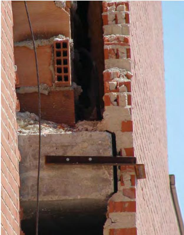
Figura 12.- Detalle del apoyo real de una fábrica en el forjado de un edificio siniestrado.
