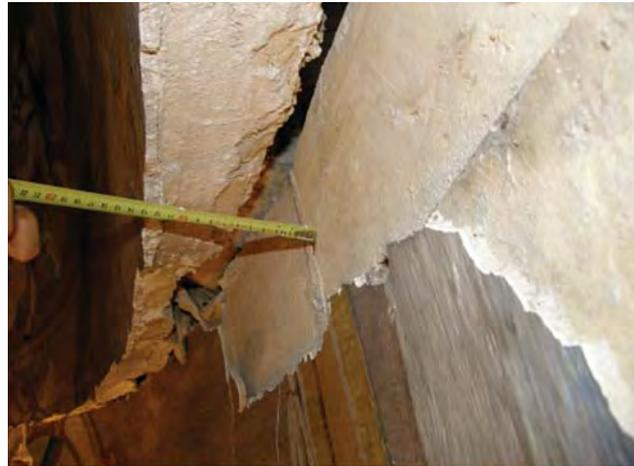
Figura 7.- Movimiento hacia fuera de la pared y pérdida de apoyo de la cúpula de la iglesia Paso Azul, Lorca.
