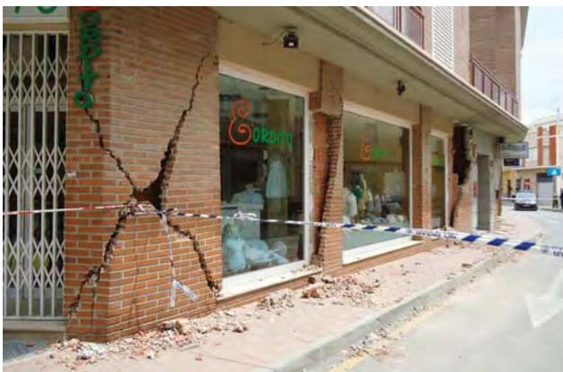
Figura 3.- Fallos en cerramientos de planta baja.
