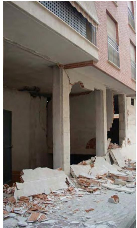
➤ **Figura 5.-** Edificio de Lorca con la planta baja débil y los cerramientos colapsados o con daños severos.
