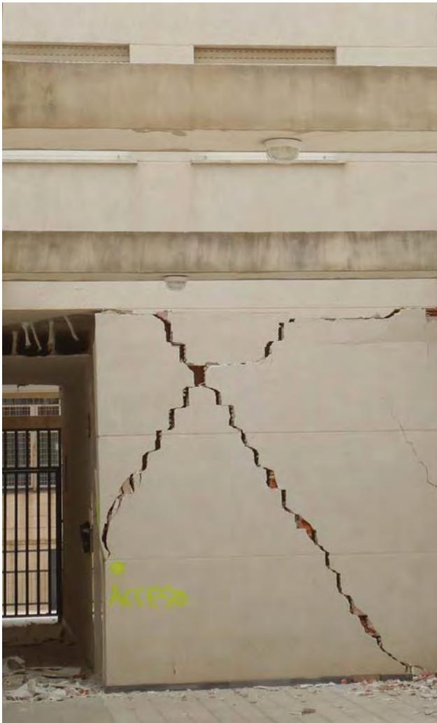
Figura 21.- Fallo de la fábrica en planta baja.
