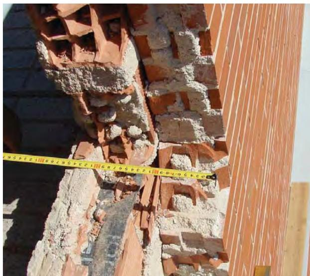
Figura 16.- Detalle de la lámina de impermeabilización que rompe la continuidad de la fábrica.
