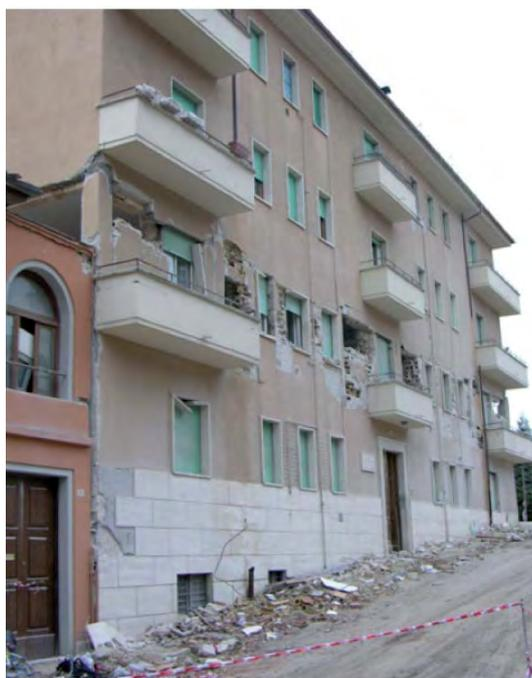
Figura 13.- Colapso de planta blanda en Pettino durante el terremoto de L'Aquila (Italia) de 2009.
