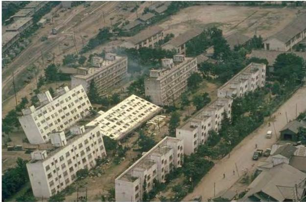
Figura 4.- Fallo de la capacidad portante de cimentaciones de edificios por efecto de la licuefacción del terreno (terremoto de Niigata, Japón, 16/6/1964).
