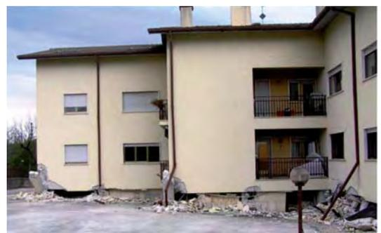
Figura 11.- Colapso de planta blanda en Pettino durante el terremoto de L'Aquila (Italia) de 2009.
