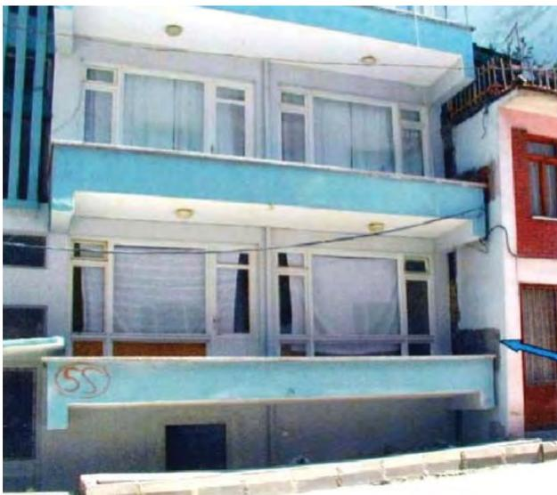
Figura 9.- Asiento de una edificación debido a la licuefacción del terreno subyacente (terremoto de Izmit, Turquía, 17/8/1999).
