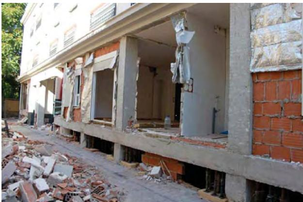
➤ **Figura 4.-** Edificio de Lorca con daños estructurales moderados en los pilares cortos, pero con grandes daños no estructurales por el colapso de los cerramientos de la planta baja.
