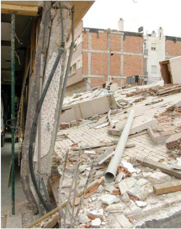
➔ **Figura 9.-** Efecto del impacto del edificio colapsado sobre el colindante.
