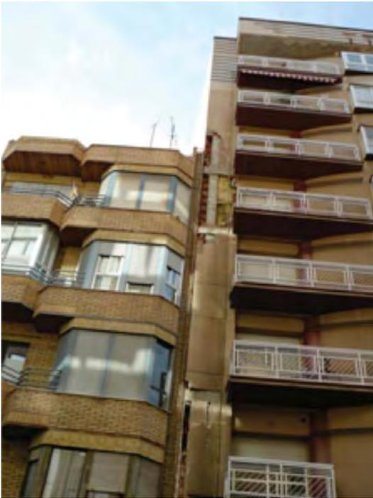
Figura 6.- Golpeteo sufrido por dos edificios de Lorca con el consiguiente daño.
