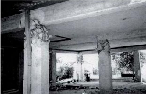
Figura 8.- Daño en extremos de pilares de planta blanda [3].
