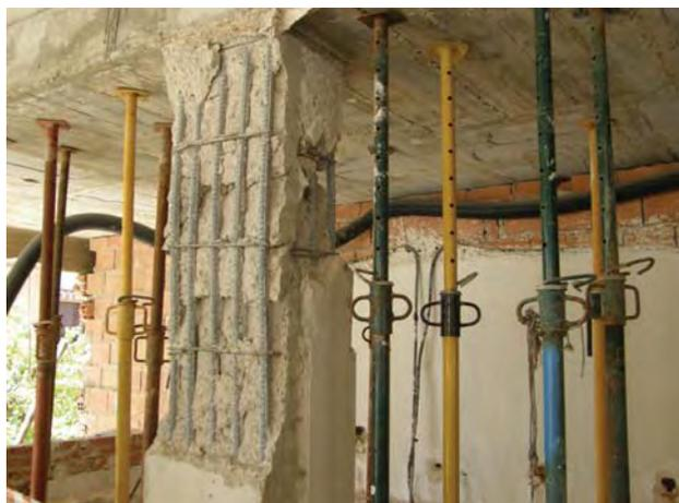
➔ **Figura 2.-** Pilar dañado en un edificio con forjados reticulares de Lorca. Se observa la falta de confinamiento.
