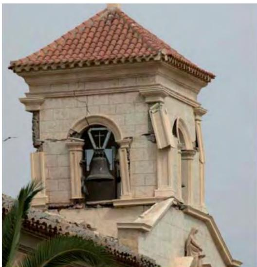
Figura 6.- Ejemplo de apéndice y del efecto de amplificación de las fuerzas dinámicas [8].
