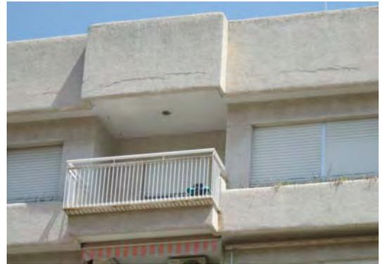
Figura 13.- Detalle de la ceja resultante de un deficiente encuentro entre el solado de cubierta y la fábrica del peto.
