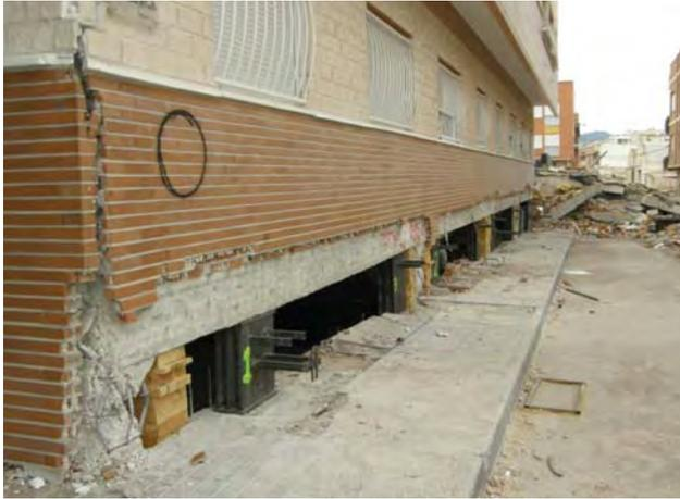
➤ **Figura 3.-** Edificio de Lorca con pilares cortos perimetrales. También es visible la falta de confinamiento en los pilares. Puede observarse "el código de Lorca": el círculo negro en la fachada que significa demolición.
